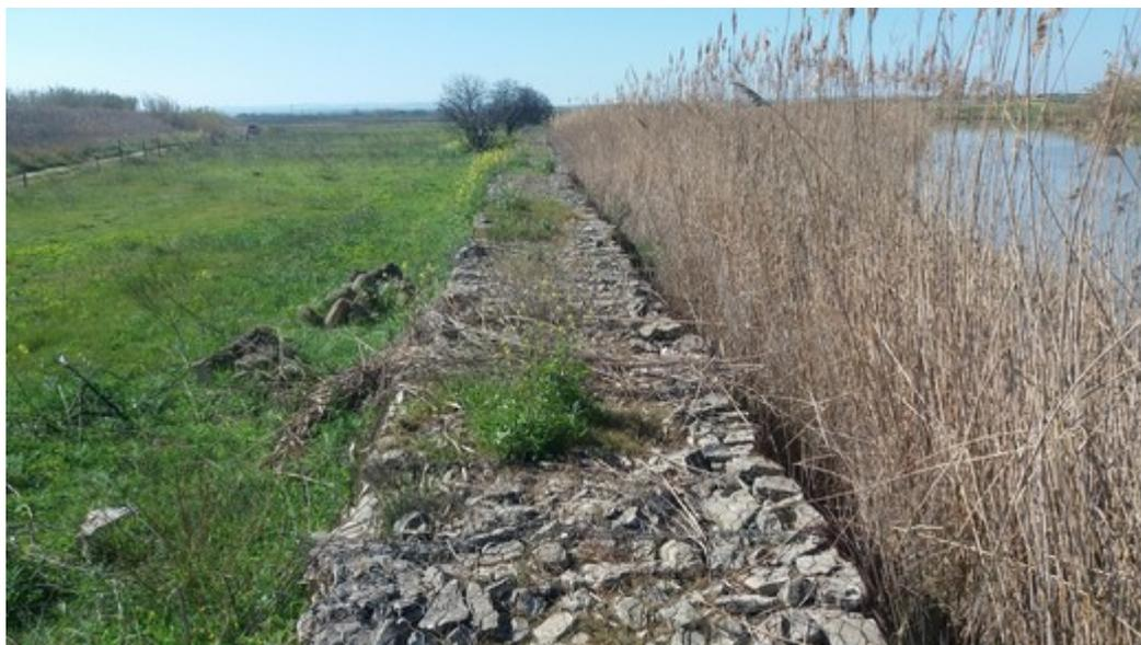
*Figura 3: gabbionate di difesa longitudinali all'interno degli argini maestri*
